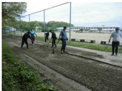
道路の整地作業
