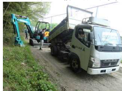
重機での作業
